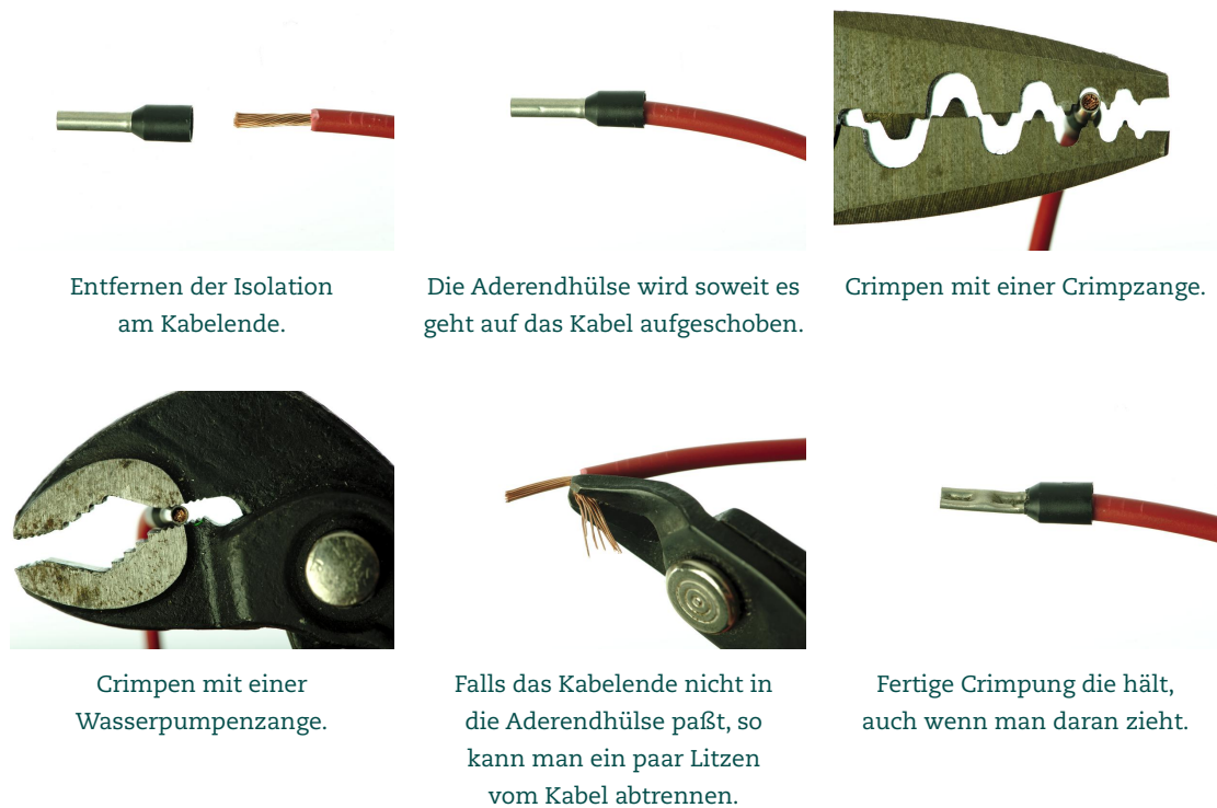
Abbildung 2 Crimpen der Aderendhülsen
